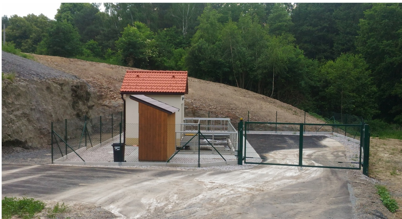
nově vybudovaná centrální ČOV Hlohová pro 350 EO
