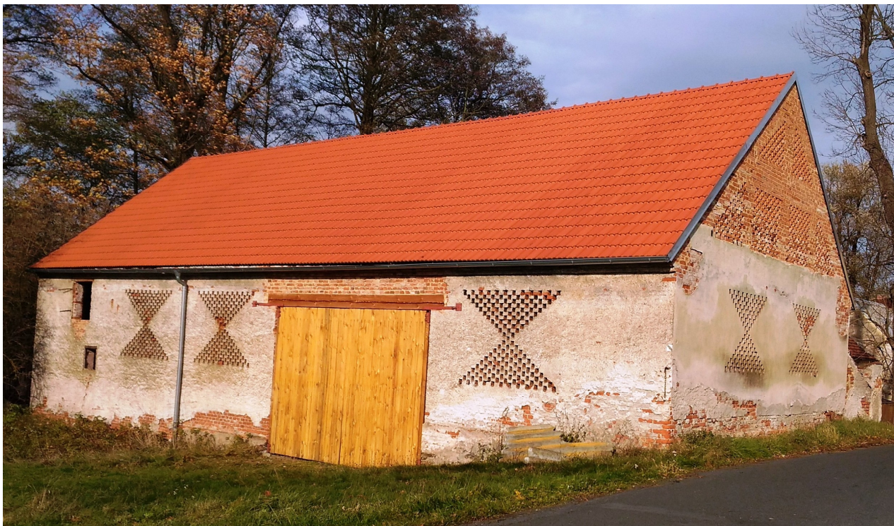
- hospodářské budovy Paseckého mlýna
